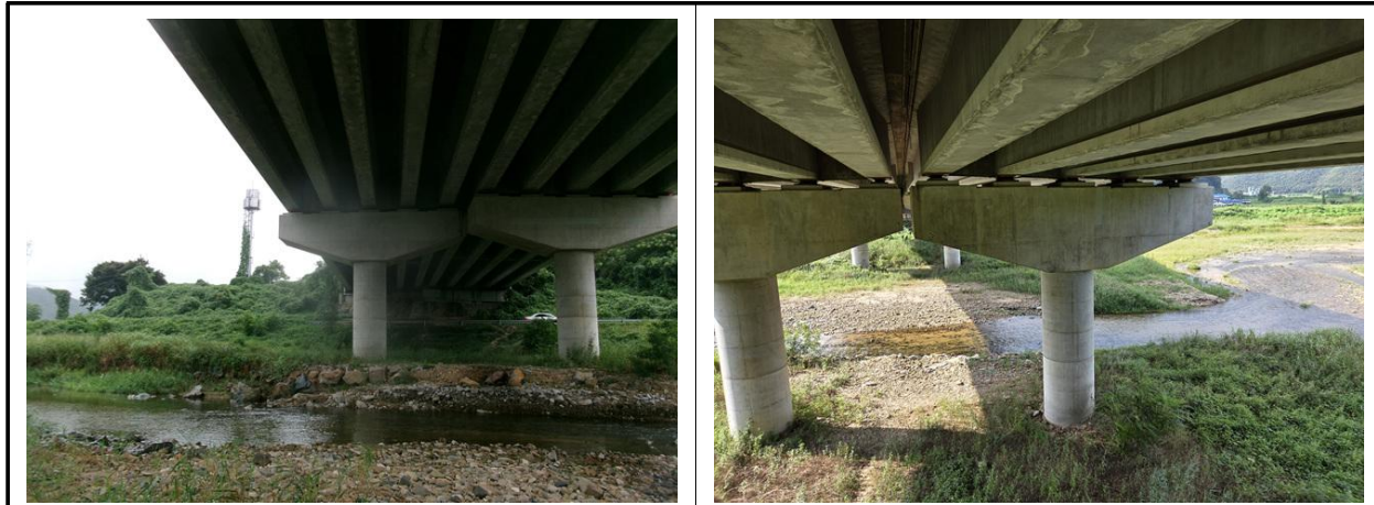
교각 코핑부 상태양호
