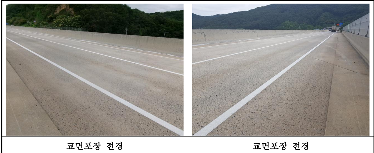
【사진 17.3.20】 교면포장 전경
