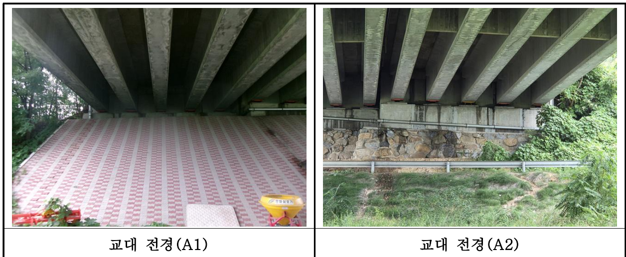
【사진 17.3.33】 교대 전경
