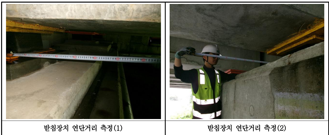
【사진 17.3.40】 교량받침장치 연단거리측정
