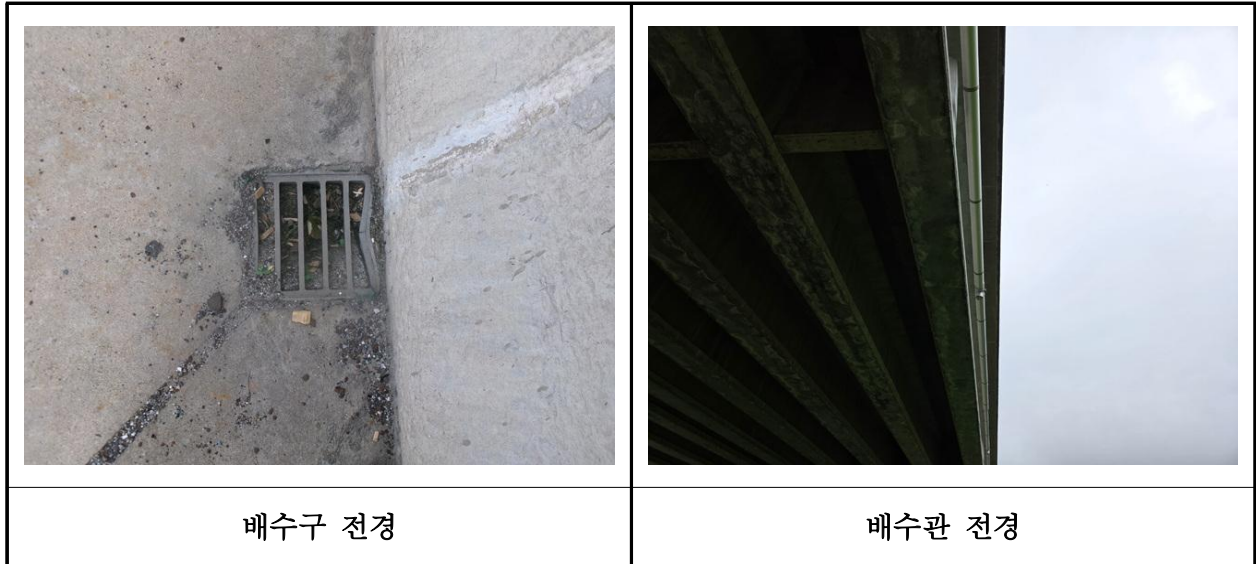
【사진 17.3.47】 배수시설 전경
