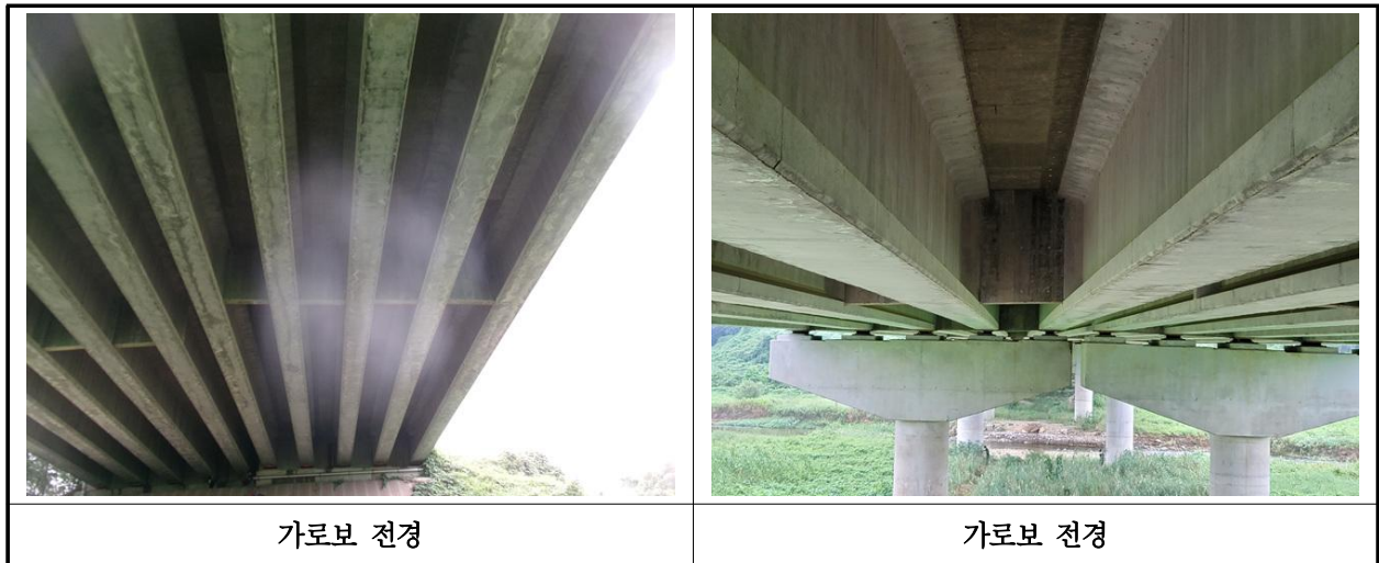
【사진 17.3.6】 가로보 전경
