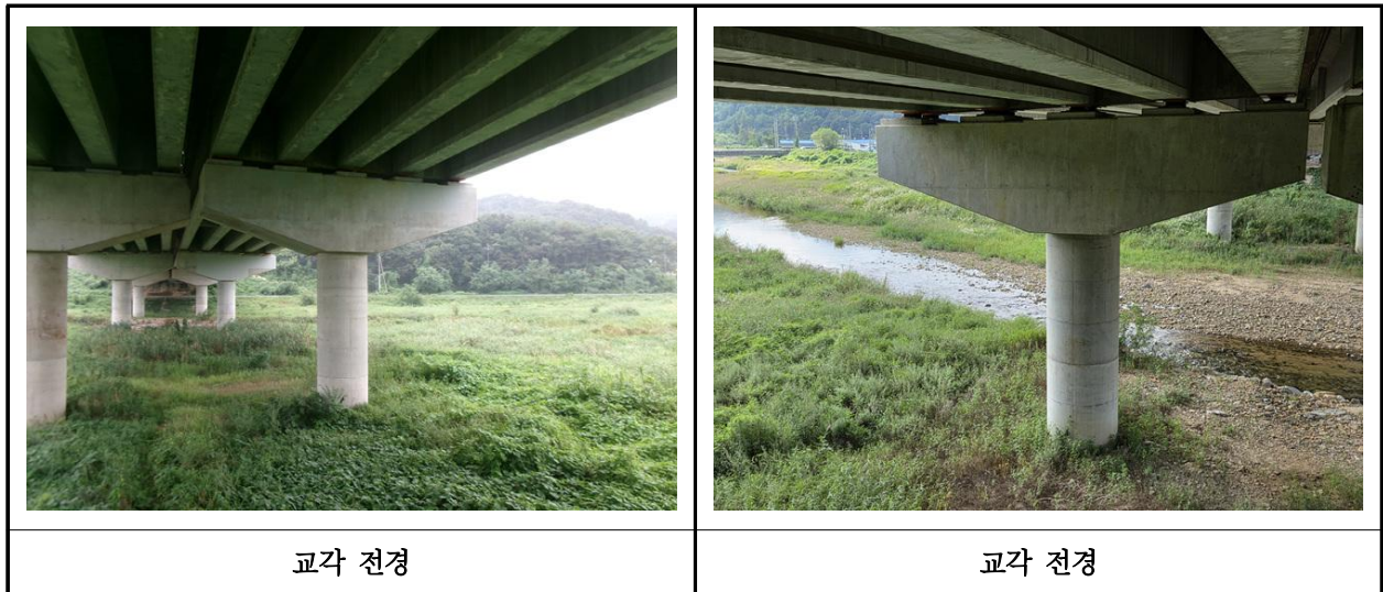
【사진 17.3.35】 교각 전경
