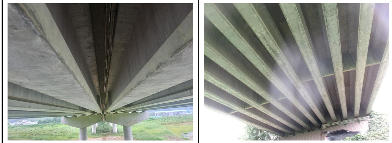
중분대 하면 상태양호
