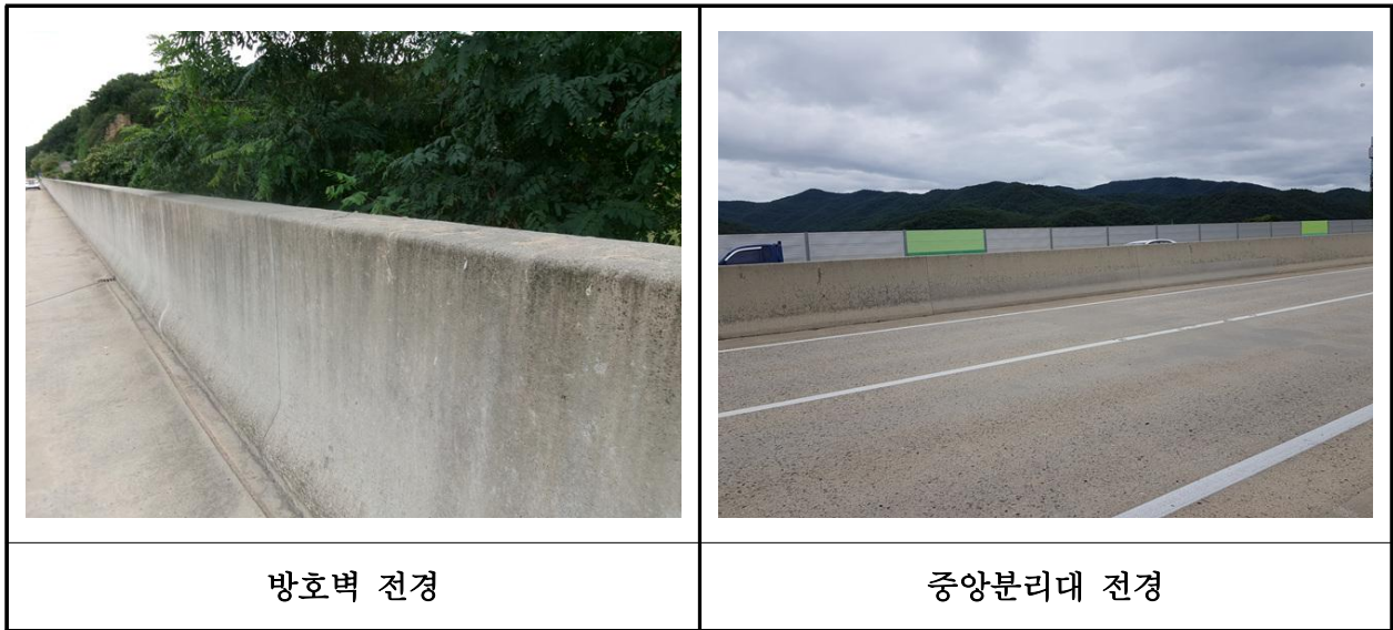
【사진 17.3.49】 방호벽 및 중양분리대 전경
