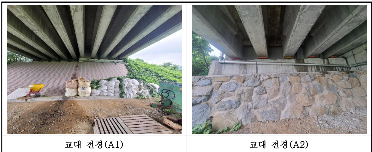
【사진 17.3.8】 교대 전경
