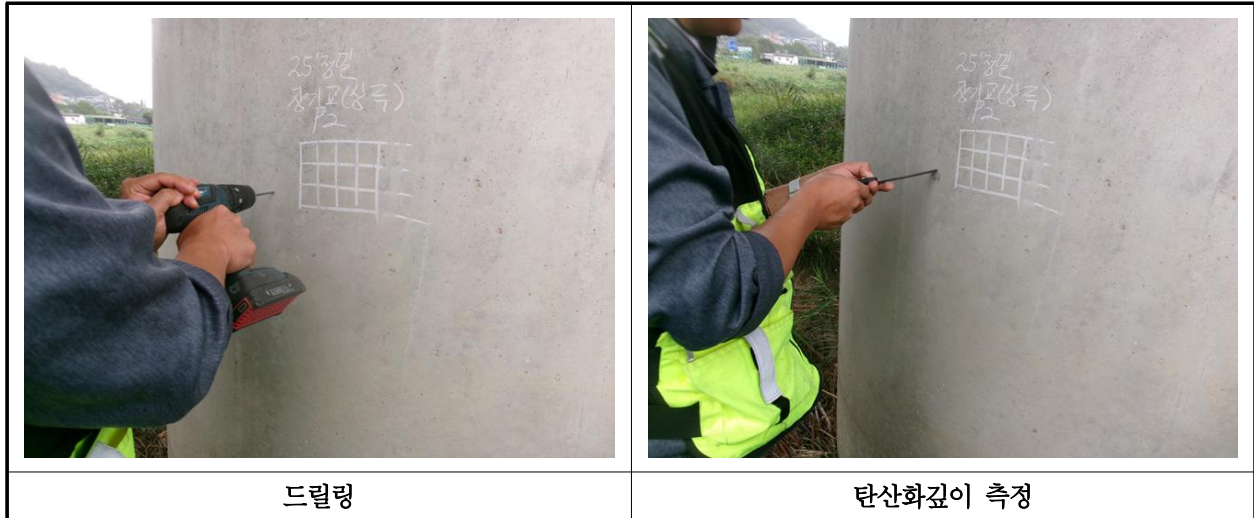
【사진 17.4.3】 탄산화 깊이 측정 현장사진
