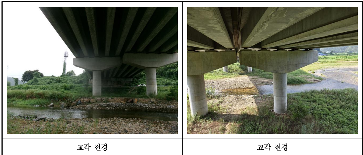
【사진 17.3.10】 교각 전경
