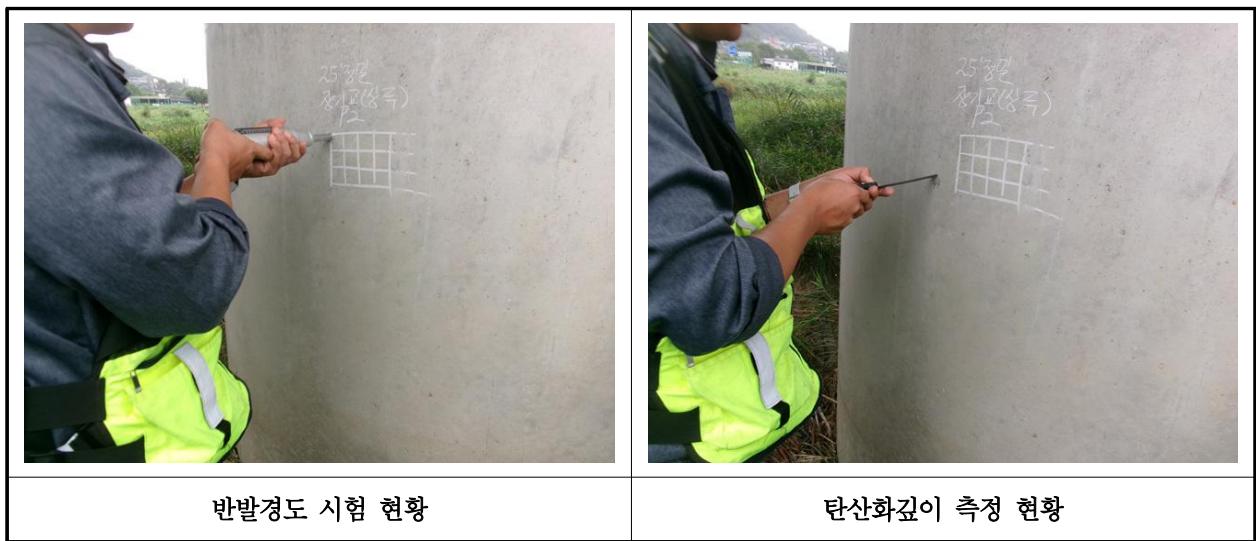
【사진 17.4.1】 콘크리트 내구성조사 현황
