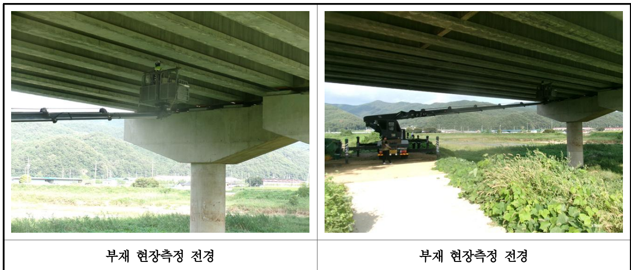
【사진 17.2.1】 부재 현장측정 전경
